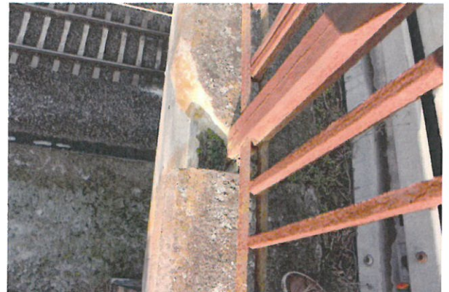
BETONABPLATZUNG GESIMS
