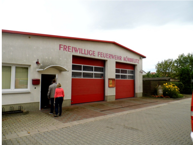
Bild 2 Ansicht Feuerwehrhaus Körbelitz
