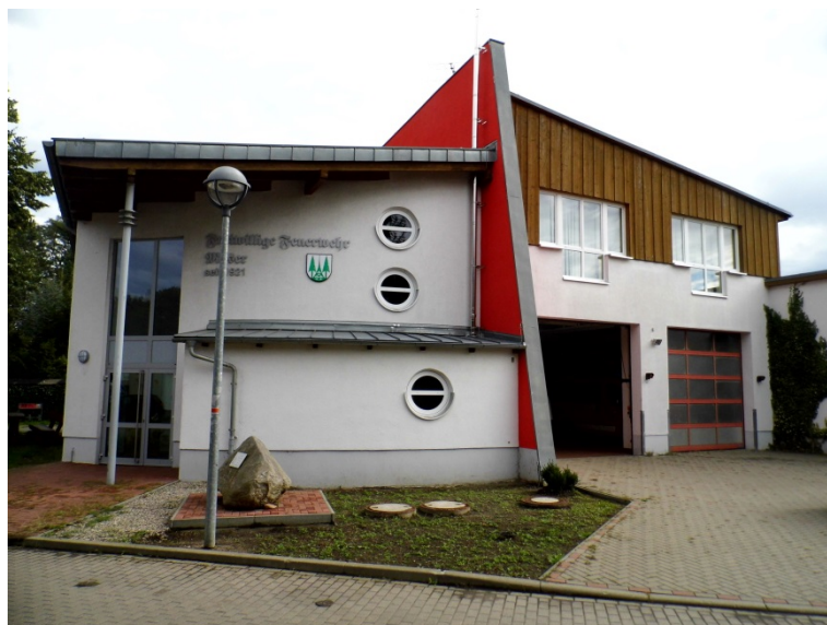
Bild 5 Ansicht Feuerwehrhaus Möser
