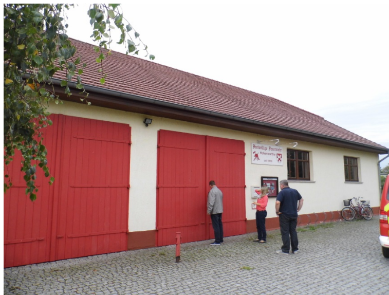
Bild 1 Ansicht Feuerwehrhaus Hohenwarthe
